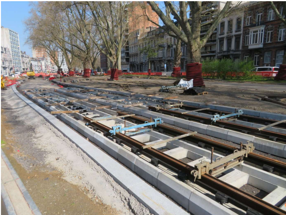
Aanleg trambaan 18 april 2023
